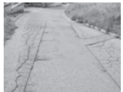
Sichtbare Asphalttrisse
